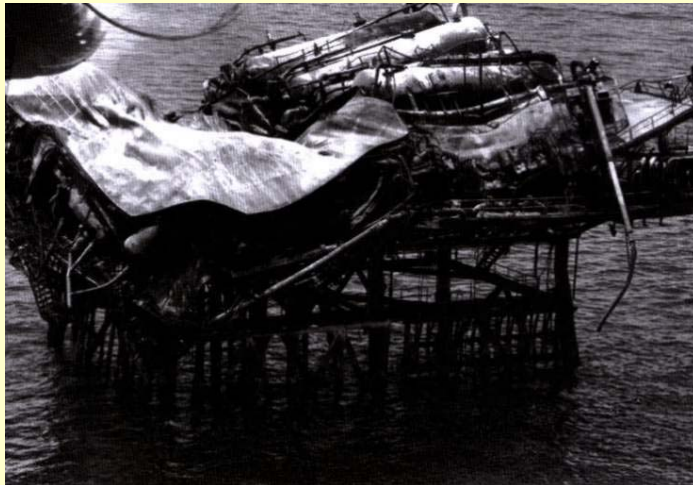
اجرای سازه های دریایی علی فاخر
